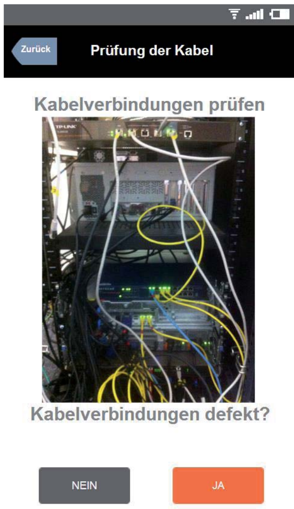
Abbildung 8: Mobile Endgeräte zur Störungsdiagnose in der Fertigung
