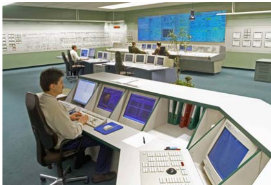
Abbildung: Simulator einer KKW Leitwarte
