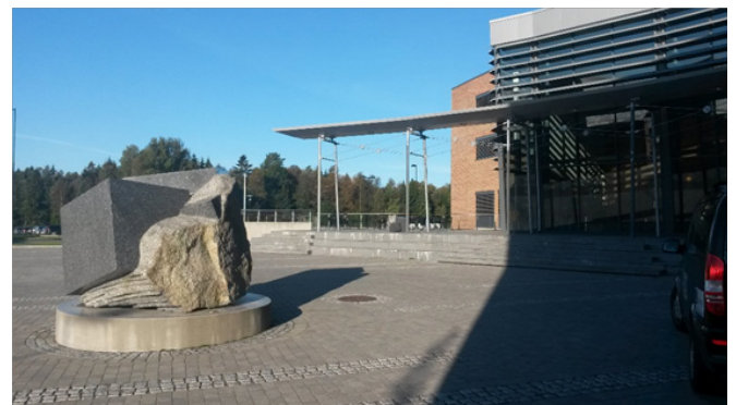
Abbildung 14: Tagungsort Innovation Center auf dem Campus der Buskerud und Vestfold University College
