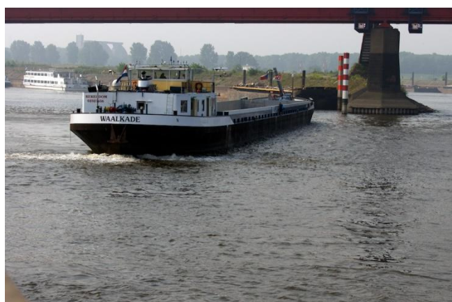
Abbildung 11: Weiteres Beispiel einer Brückendurchfahrt (Foto: Copyright Nikolaj Borisov), eingefügt durch die Newsletter-Redaktion.
