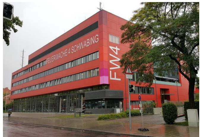
Ein Blick auf die Integrierte Leitstelle in der Feuerwache 4 von außen.
